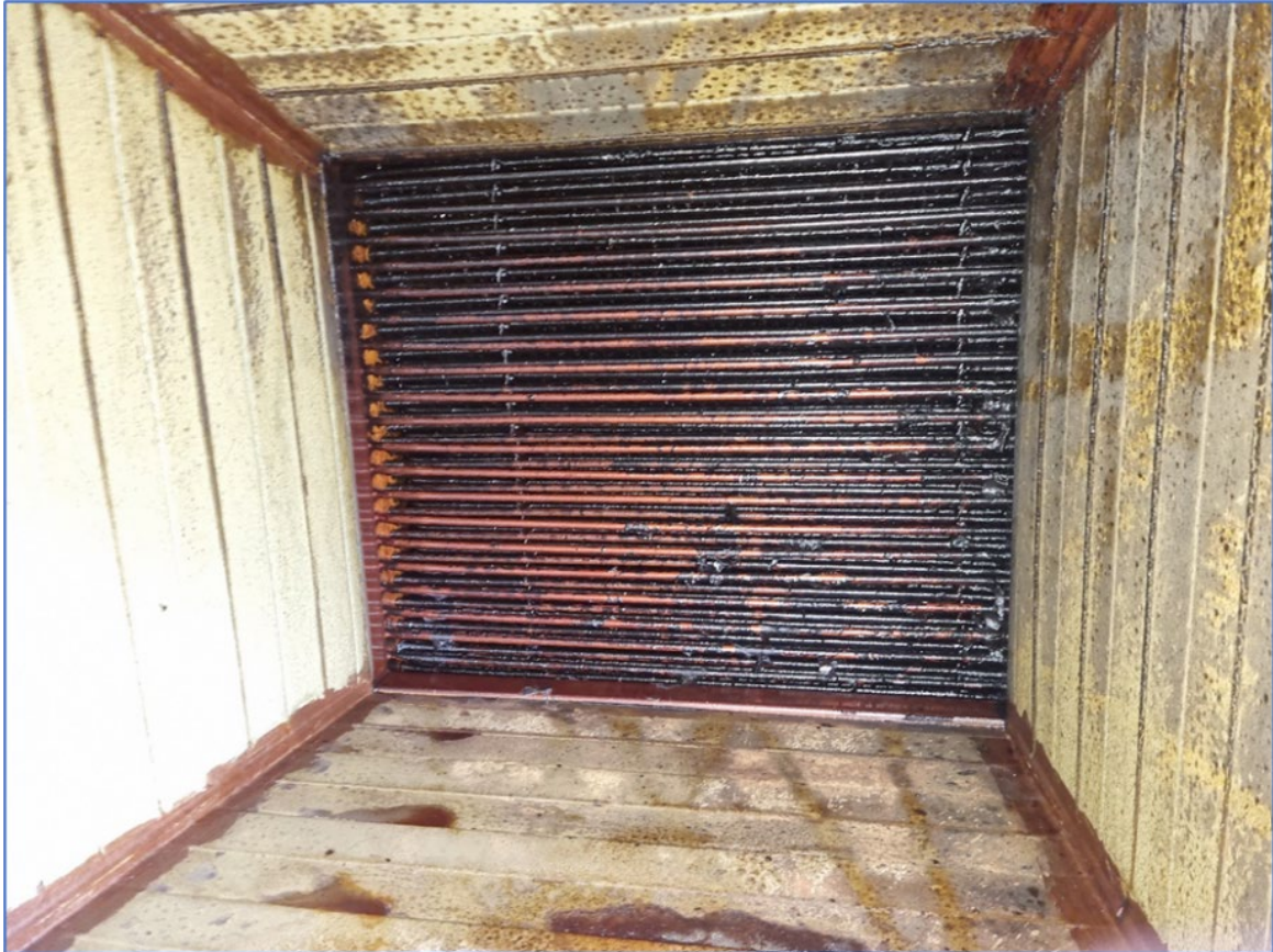
Figur 4. Foto taget på Lepido i luftflödesriktning efter 22 månaders drift utan service eller underhåll
